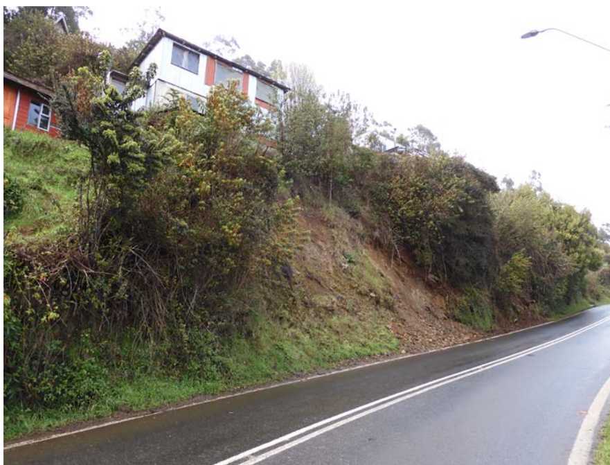
Ilustración 3-22 Ejemplo de deslizamiento de suelo en San Ignacio, ruta T-352.
