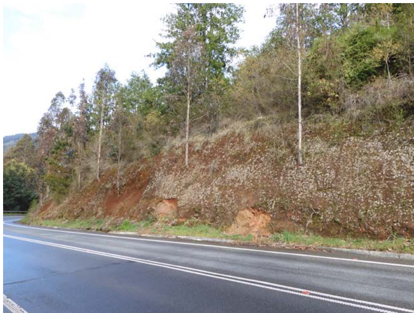
Ilustración 3-23 Ejemplo de deslizamientos menores camino a Huellehue, ruta T-35.
